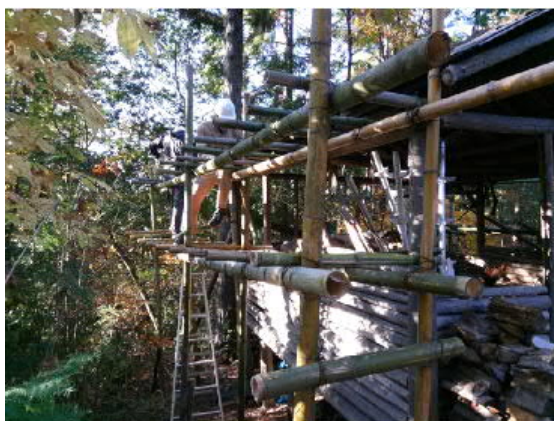
雨漏りがひどくなってきた小屋の 屋根補修のための足場づくり 2020年11月
